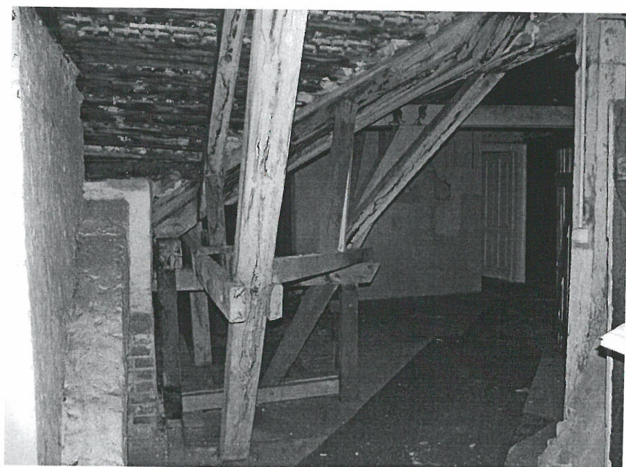
FOT.11 Przebudowana więźba dachowa pod koszem od strony płn.
