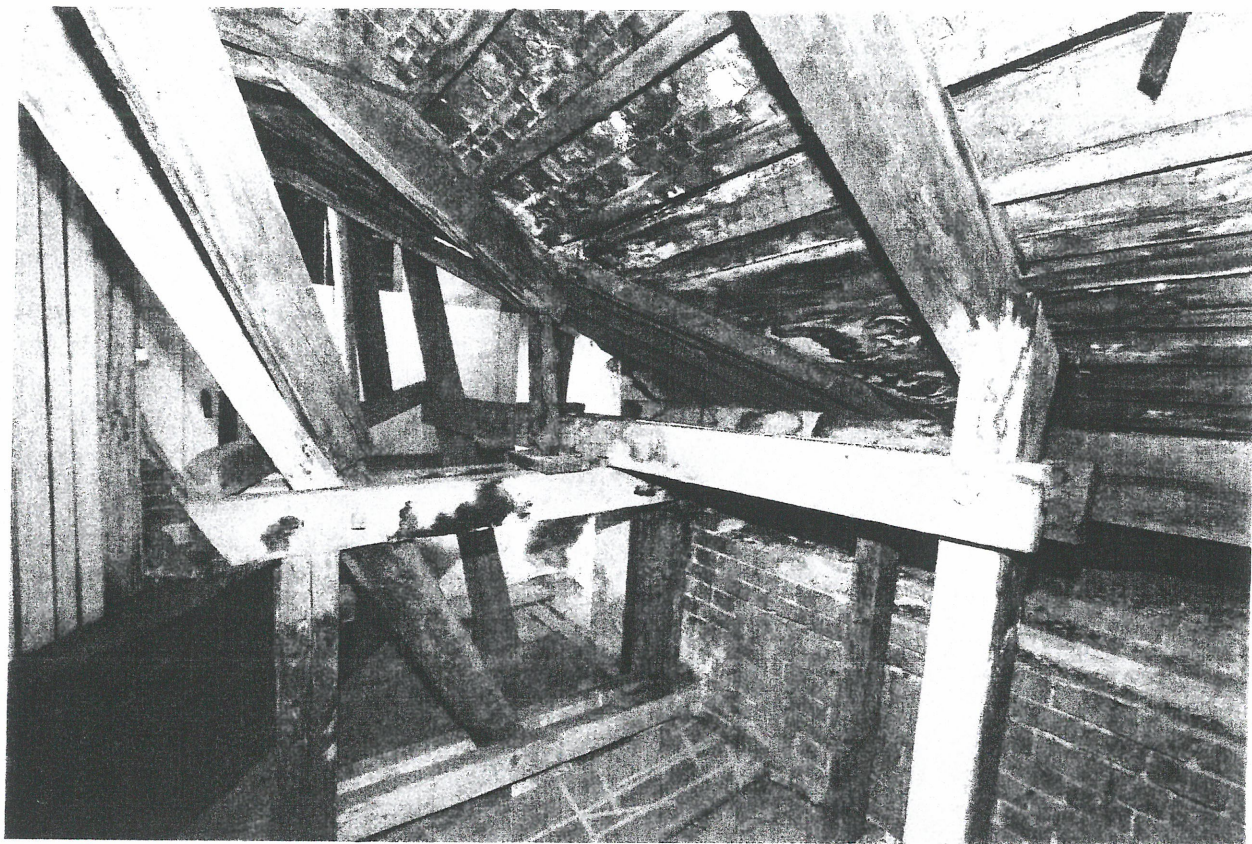
Fot. 9. Konstrukcja kosza dachu skrzydła południowego.
