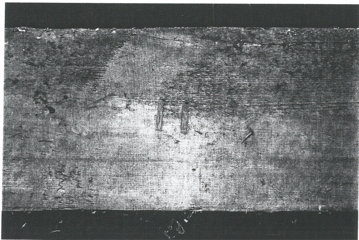
Fot. 12. Ciesielskie oznaczenia montażowe na elementach więźby.
