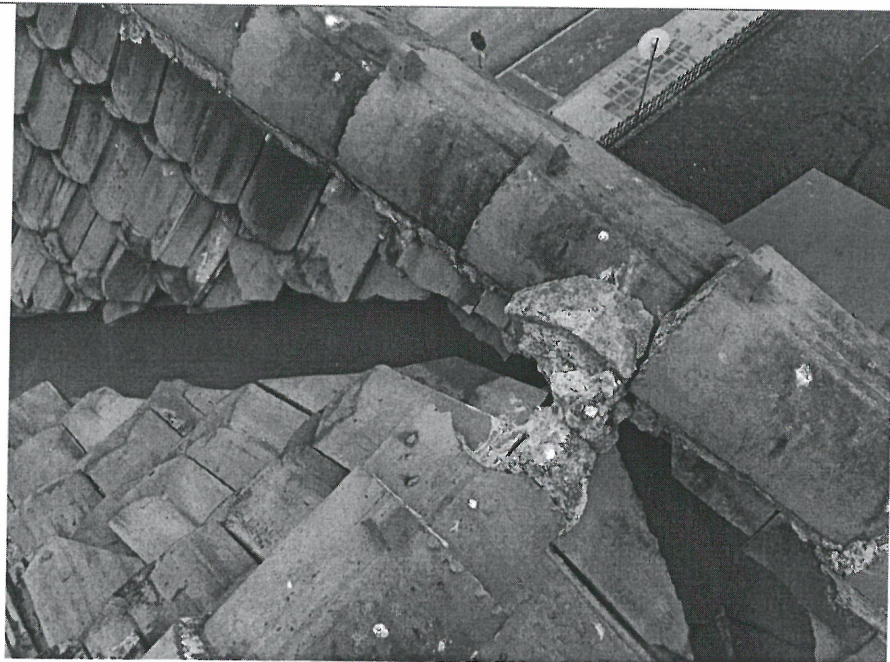
FOT.9 Węzeł kalenicowy od strony północnej
