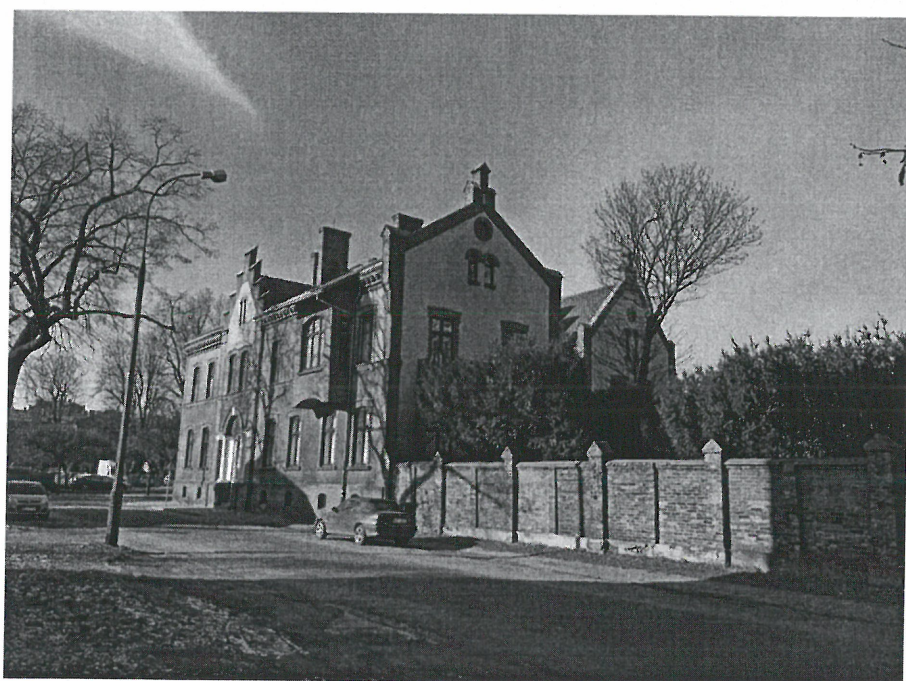
FOT.4 Plebania od strony południowej
