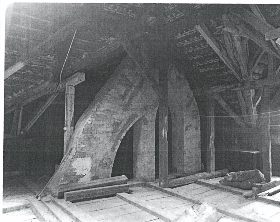
FOT.24 Wieżba w strefie środkowej; widok w kierunku oficyny
