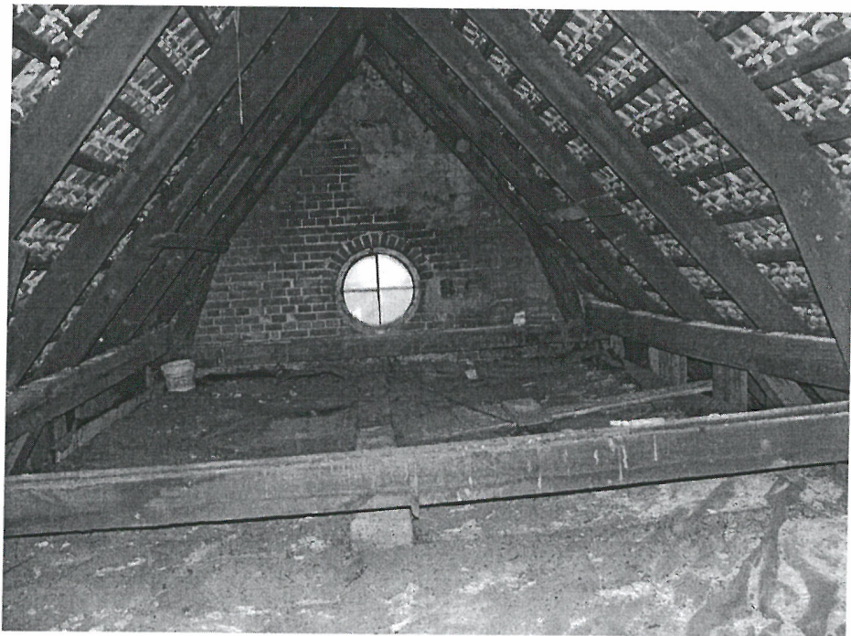
FOT.13 Więźba nad blokiem od strony północnej
